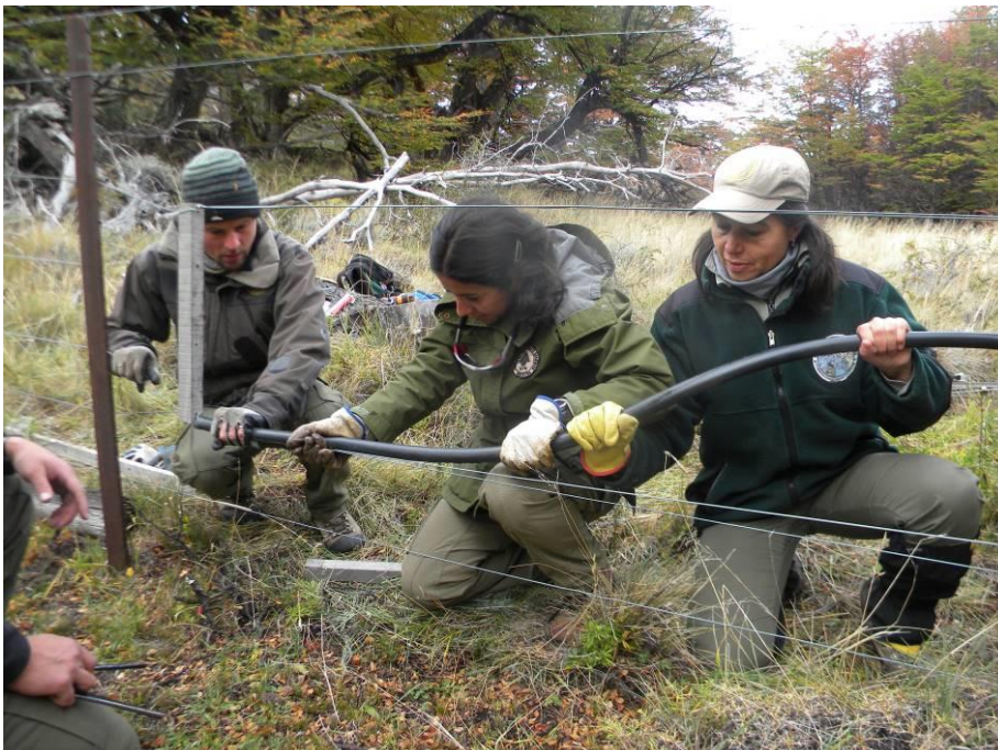
Figura 3. La colocación de una manguera de pvc sirve tanto para aumentar la probabilidad de detección del paso por parte de la fauna, como para evitar enganches o lastimaduras.
